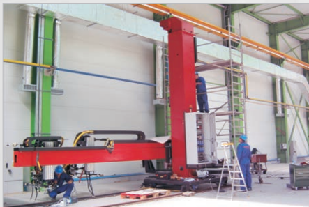
Installation et mise en route chez le client.
